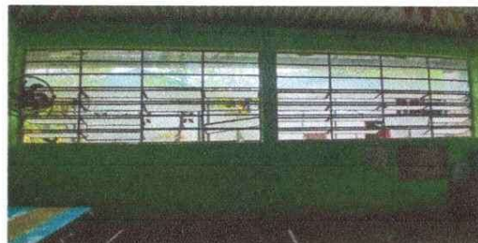
FOTO 14: Fabricación e instalación de puertas de metal en módulos 3
