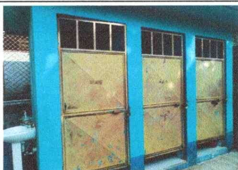
FOTO 9: Mantenimiento a estructura (lijado, cambio de tubo, cepillado, sujeciones, aplicación de pintura) a puertas servicios sanitarios
