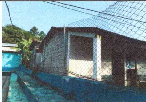
FOTO 10: Reparación de tubo hg y malla galvanizada
