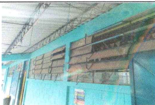
FOTO 7: Fabricación e instalación de ventana-balcon de metal
