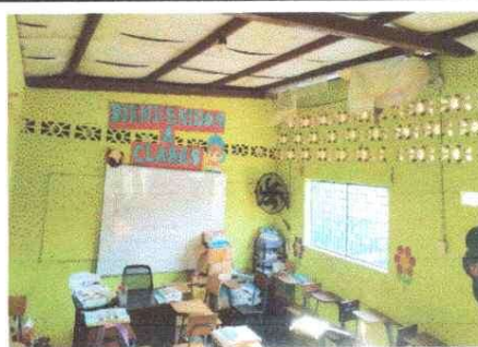
FOTO 6: Repello en muro
