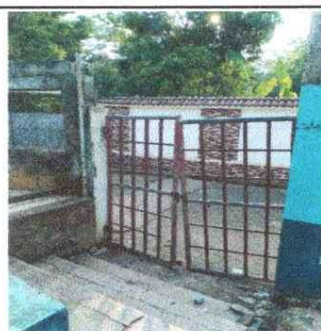
FOTO 12: sustitución de porton de metal
