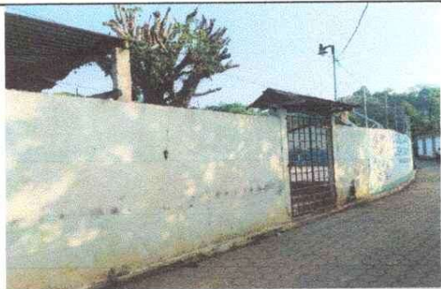
FOTO 5: Pintura en muros exteriores e interiores
