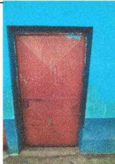
FOTO 8: Fabricación e instalación de puertas de metal en módulos
