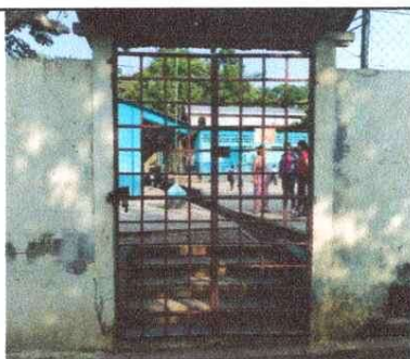
FOTO 11: sustitución de porton de metal
