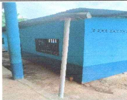
FOTO 4: Sustitución de canal de metal
