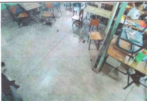
FOTO 3: Sustitución de piso cerámico
