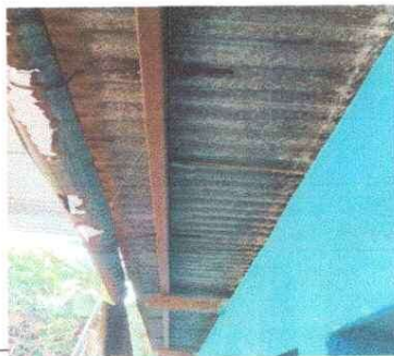
FOTO1: Sustitución de lámina, por lámina troquelada aluzinc calibre 26
